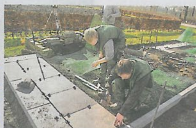
Die Platten werden in Dränmörtel gesetzt. Zu achten ist auf Gefälle für den Wasserablauf.
