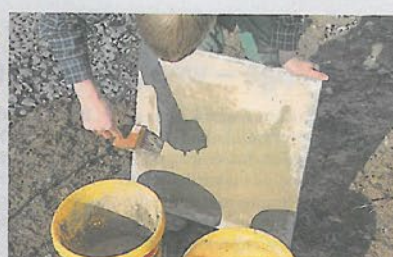
Die Platten verbinden sich besser mit dem Mörtel, wenn sie mit Haftschlämme eingestrichen werden.
