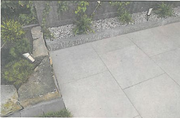
Zur Einfassung der Keramikflächen werden Natur- oder Betonsteine eingesetzt.
