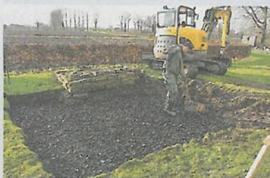
Der Unterbau aus dränfähigem Schotter wird schichtweise eingebracht und abgerüttelt.
